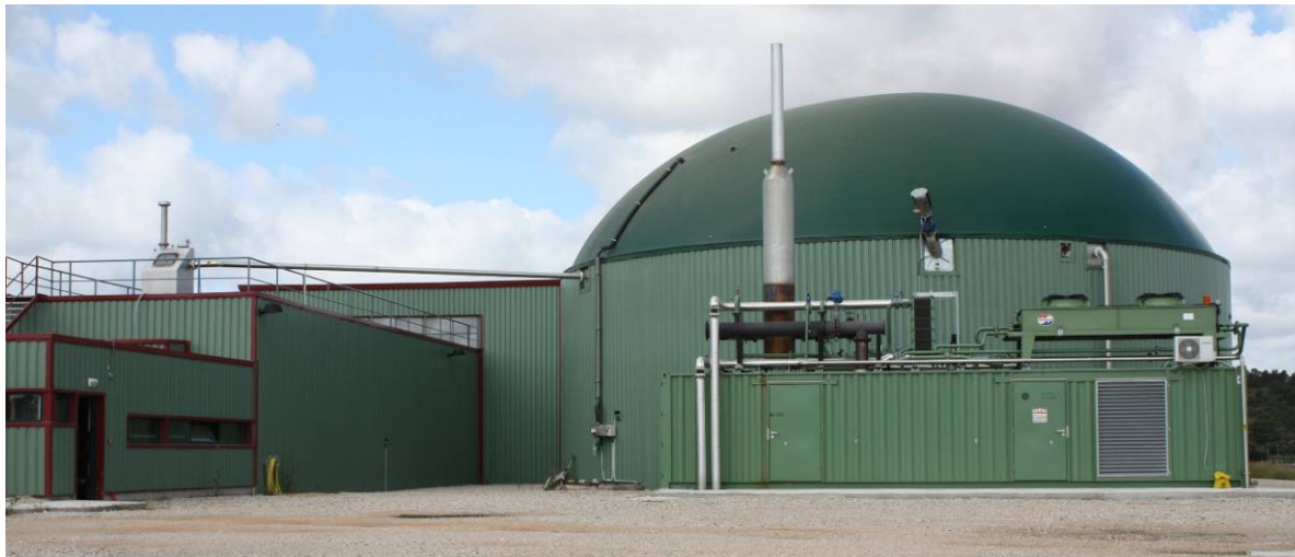
Planta de biogás a escala real (GSR) donde la validación industrial se llevará a cabo
